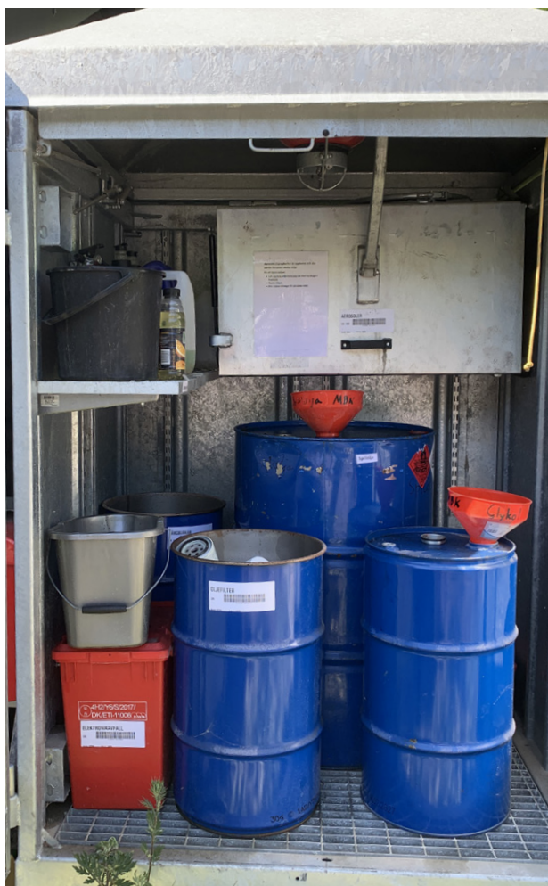
Miljöstation för farligt avfall.
